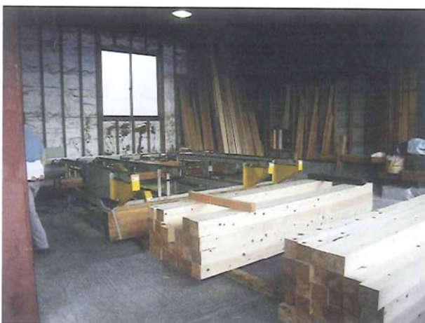
図 3.16 モルダーによる仕上げ
